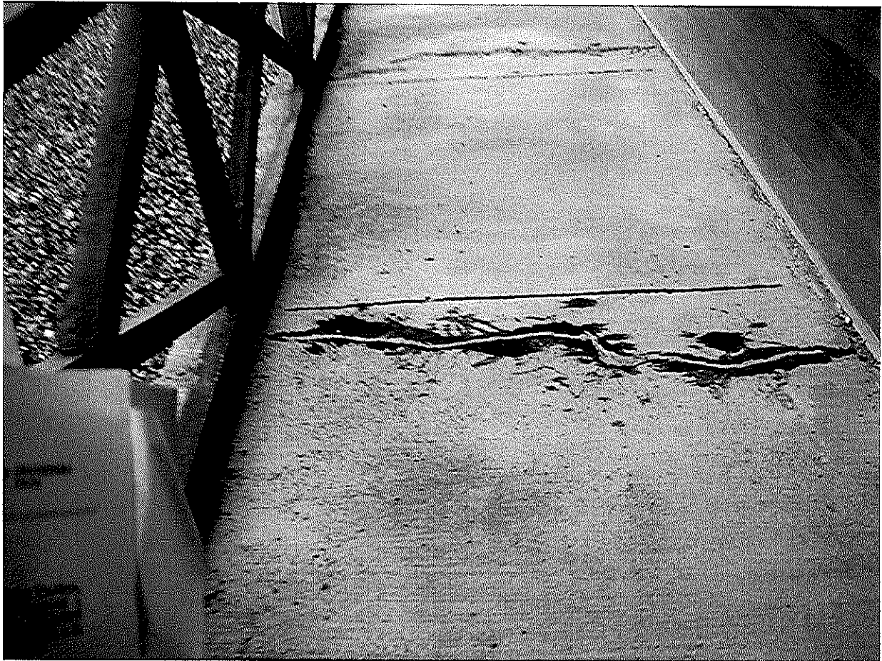
Imagen N° 7 – Fisuras en aceras
