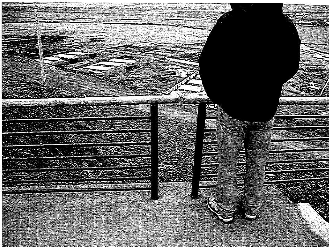
Imagen N° 2 – Separación entre barandas.
