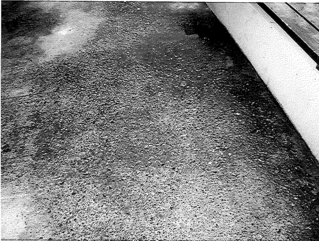
Imagen N° 5 – Desgaste prematuro en aceras.
