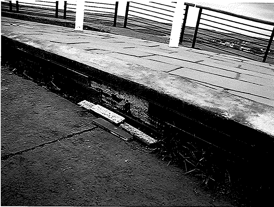
Imagen N° 3 – Enchapes sueltos y caídos.
