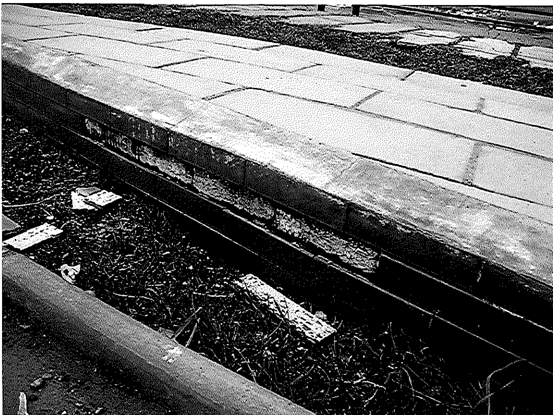
Imagen N° 4 – Enchapes sueltos y caídos.
