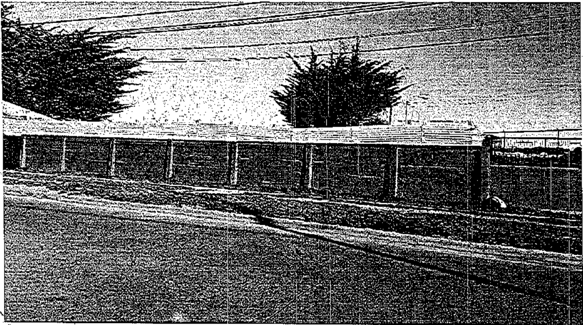
Fotografía N° 1. Vista Exterior: Se constata la inexistencia de protección de fierro sobre muro, tipo pino guardián.
