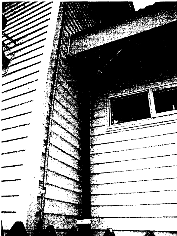
Imagen N°48, Sede N°16, San Miguel. Tubería ventilación no cumple altura.
