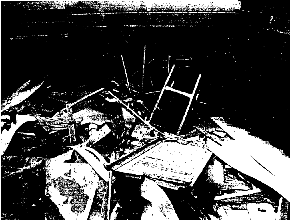
Imagen N°5, Sede N°40, 21 de Mayo. Escombros dejados por el contratista.
