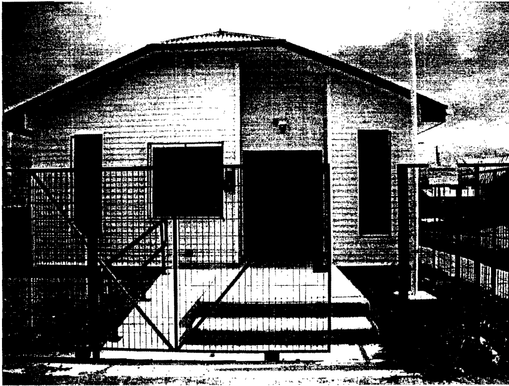
Imagen N°65, Sede N°22, Mateo de Toro y Zambrano. Portón deficiente.
