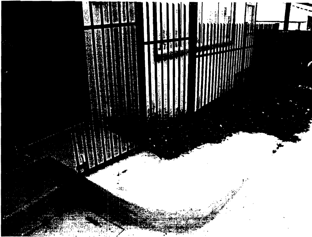
Imagen N°49, Sede N°28, Cerro de la Cruz. Falta baranda para minusválidos.
