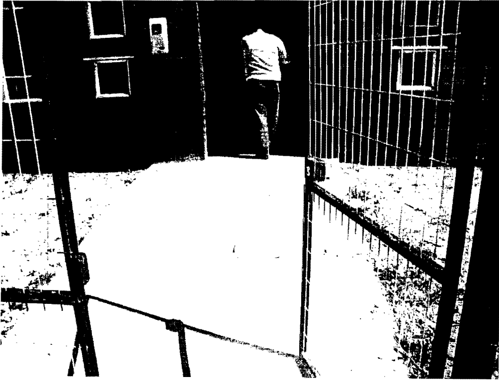
Imagen N°7, Sede N°41, Villa las Nieves. Faltan pasamanos de acceso.
