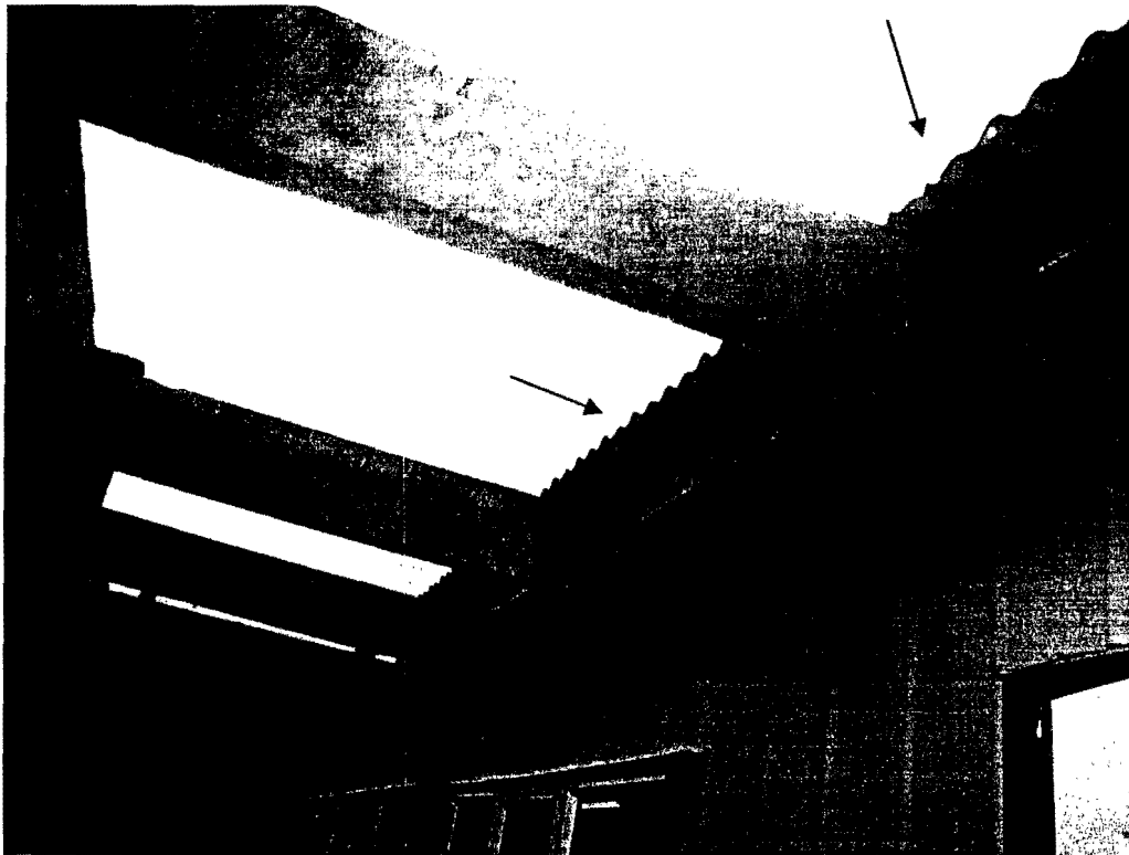
Imagen N°76, Sede N°18, 12 de Octubre. Falta de canales de aguas lluvias.
