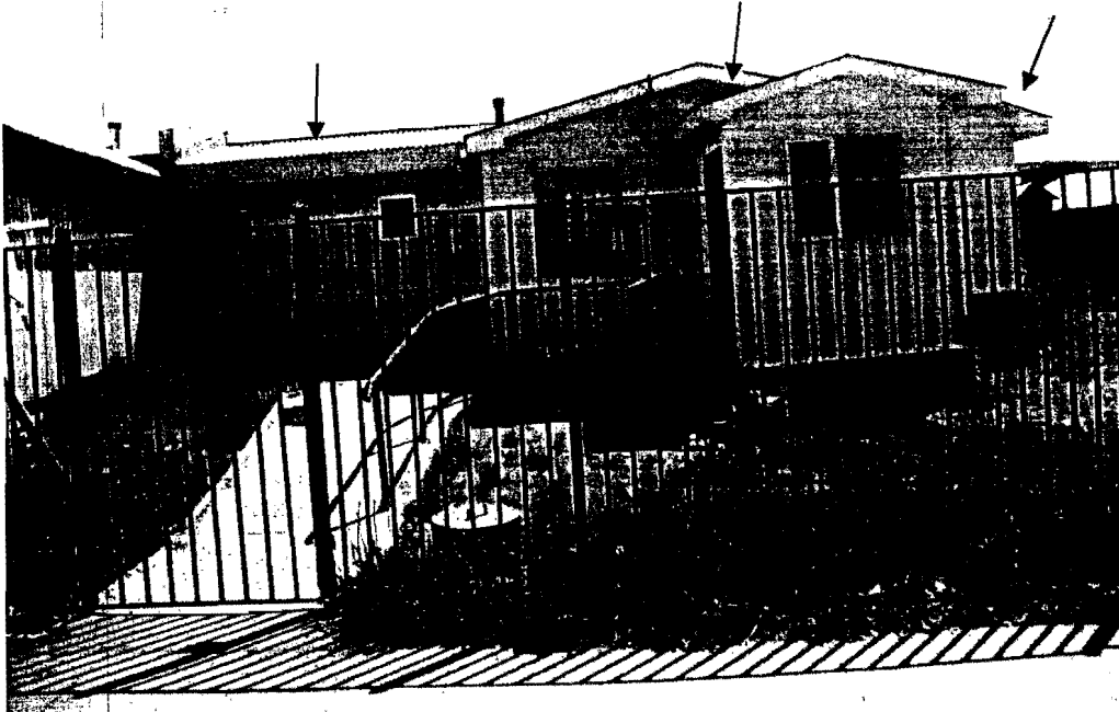
Imagen N°23, Sede N°38, Seno Almirantazgo. Falta de canaletas de aguas lluvias.
