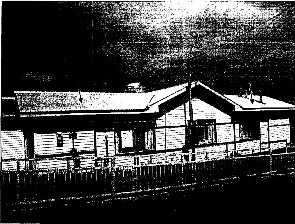
Imagen N°14, Sede N°36, El Pingüino. Falta de canaletas de aguas lluvias.
