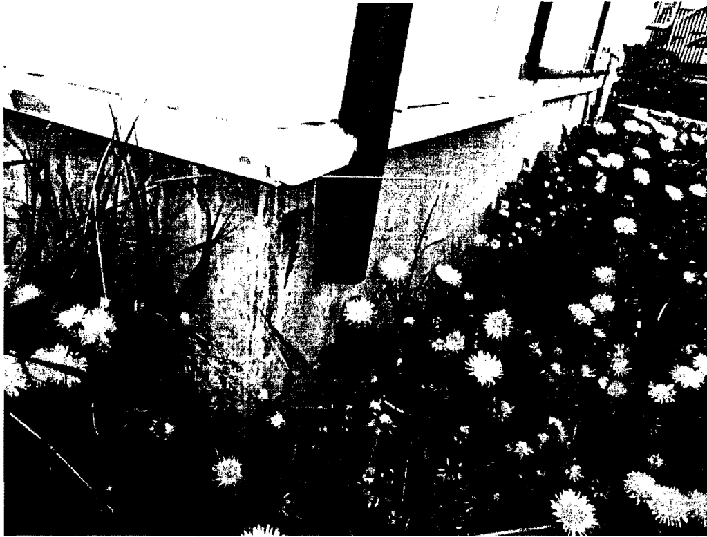
Imagen N°39, Sede N°23, Carlos Bories. Aguas lluvias apozan al interior.
