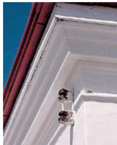
*Detalle molduras remate de techumbre, y aislador de recepción telefónica del faro Punta Delgada*
