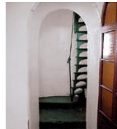
*Acceso a la base de la torre del faro Punta Delgada destacándose los espesores de muro, su coronación circular y la delicada forma de la escalera de fierro fundido*
