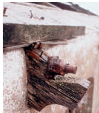
*Remate de la viga de madera y tensor de arriostramiento del faro Isla Magdalena (utilizado en todos los faros con techumbre de madera)*
