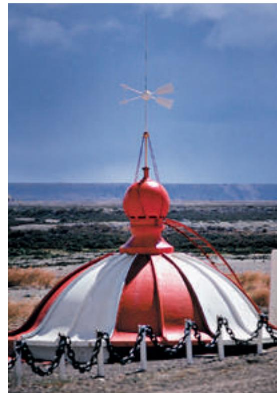
*Detalle de la cúpula original constuida en cobre emballetado*
