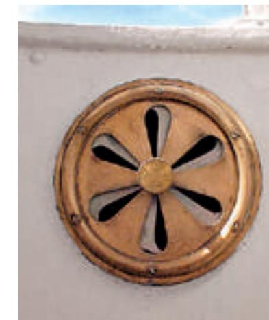
*Sistema de ventilación de bronce para no permitir que se empañen los cristales de la linterna (utilizado en todos los faros)*
