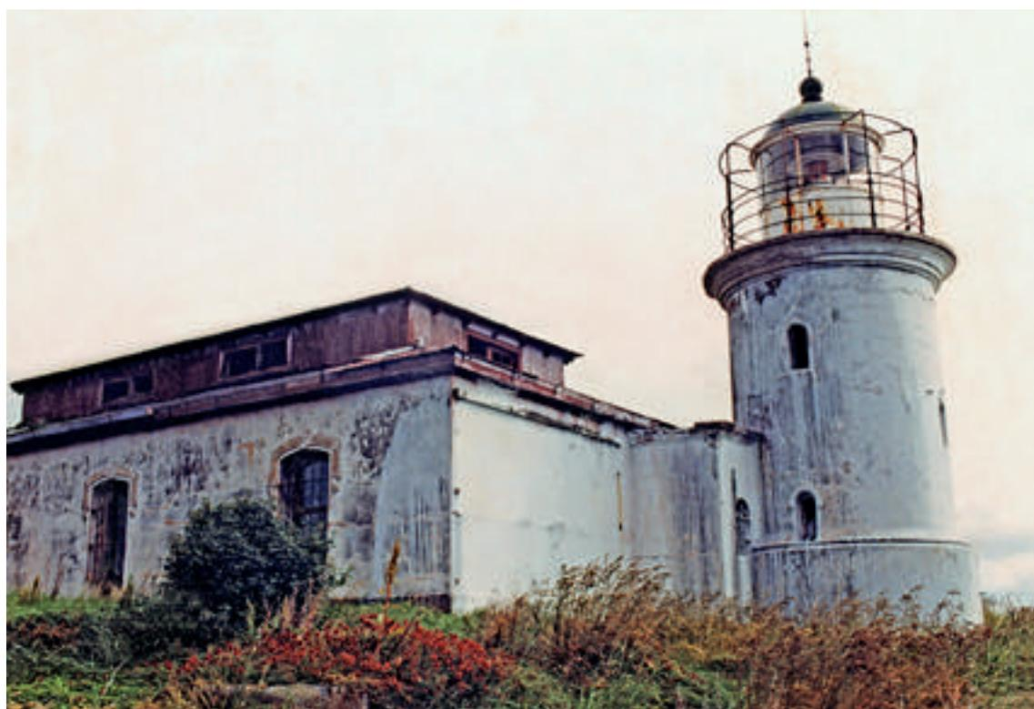
Ubicado en el hermoso paraje del cabo San Isidro se construyó este faro de mayores dimensiones. Su base rectangular, de albañilería reforzada, tiene la particularidad de la incorporación del uso de la madera para toda la estructura de techumbre, con un volumen interior más alto que permite el acceso de luz natural
