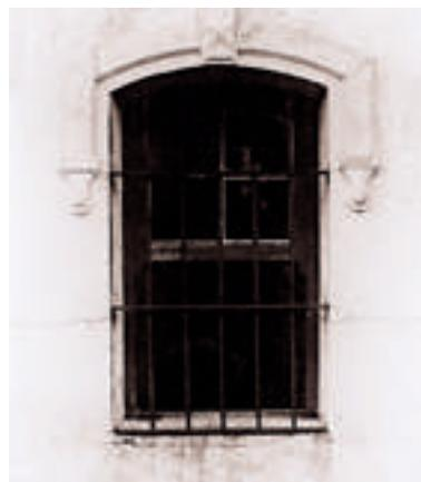
*Detalle de ventana de guillotina y protección de hierro forjado con sobrerrelieve y arquitectura superior (arco de medio punto)*
